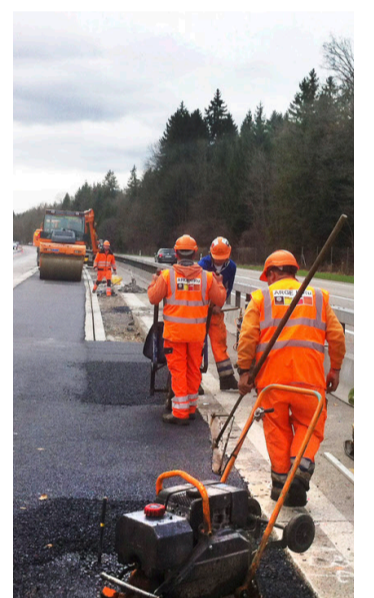
Wo die Bauarbeiter zu sehen sind, rollt demnächst der Verkehr.
